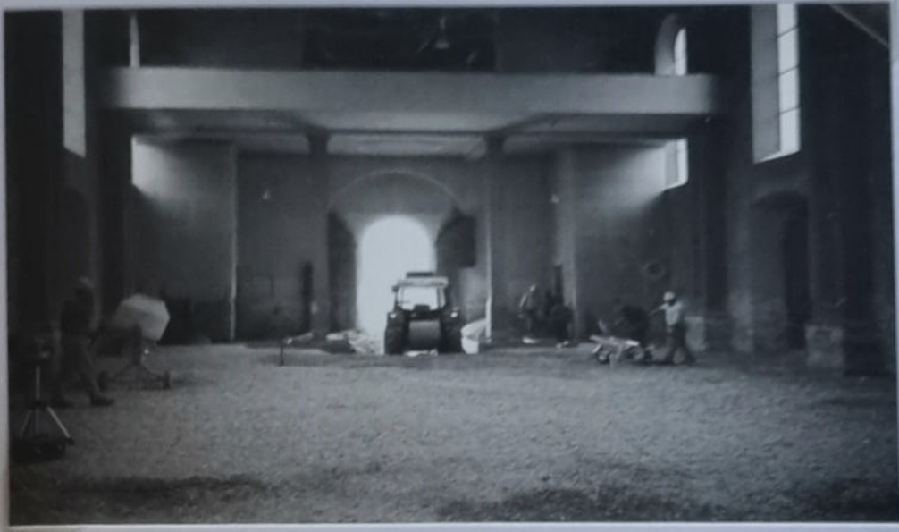
Vor dem Auffüllen mit Kies
