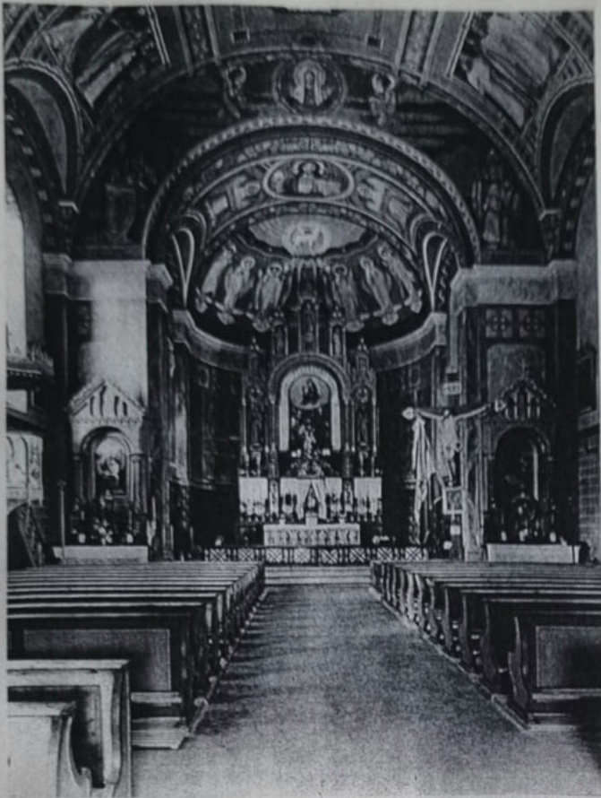
Roppen, Pfarrkirche hl. Leonhard, Innenansicht, Zustand um 1930 Foto: BDA Innsbruck
