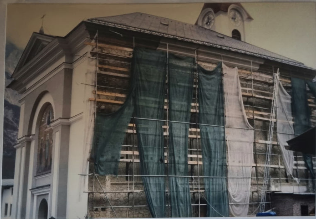
Renovierung der Südseite · 1989
