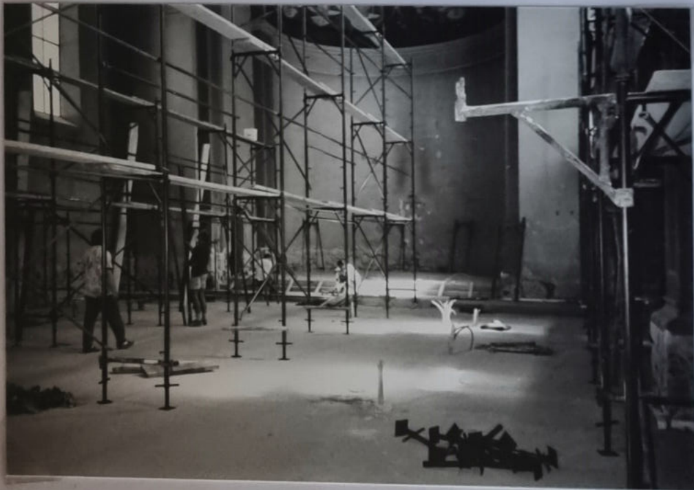
Gerüst für die Renovierung des Deckengemäldes
