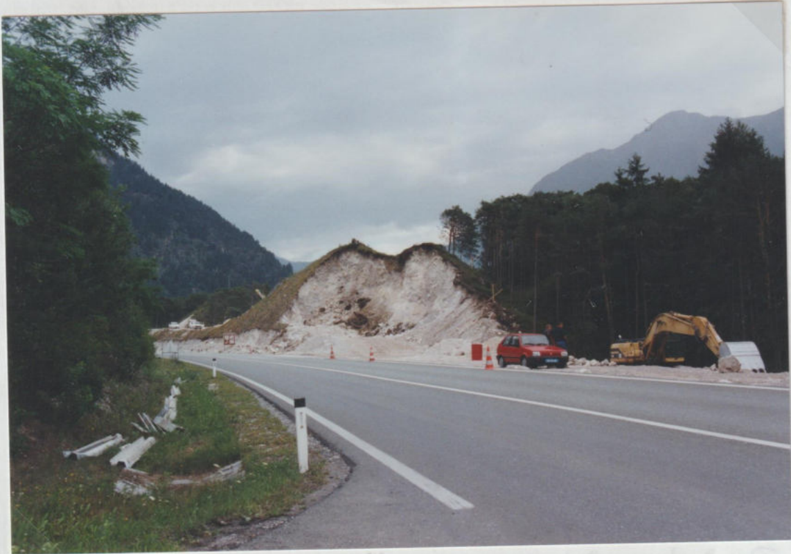
Bau der Zufahrt vor der Autobahn in Richtung Roppen (Abkürzung)
