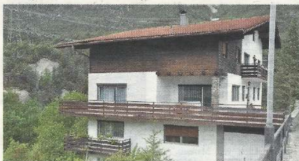
Mehr als zwölf Betten sind laut Widmung im ehemaligen Wettsteinhaus nicht möglich.
