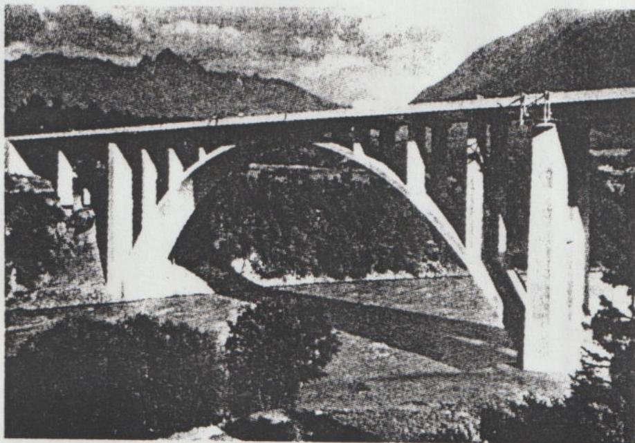
Diese Stahlbetonbogenbrücke wurde ebenfalls im Zuge des Ausbaus der Wiener Bundesstraße errichtet: Gesamtlänge (einschließlich Bahnübersetzung) 235 m, 68 m lichte Weite und 26 m Höhe des Bogens.
