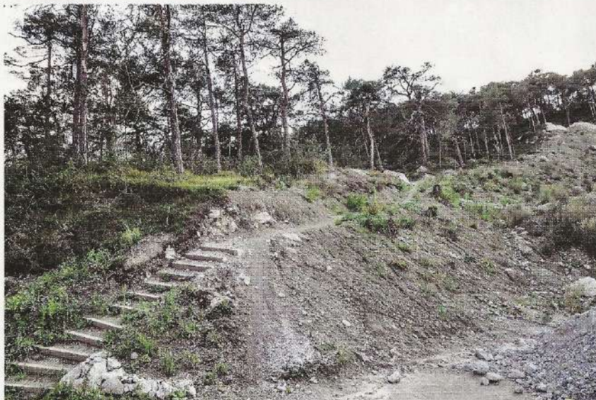
Der durch die dritte Ausbaustufe beim Gewerbepark abgeschnittene Zustieg zum Geolehrpfad wurde von der Naturwerkstatt wieder instand gesetzt.
