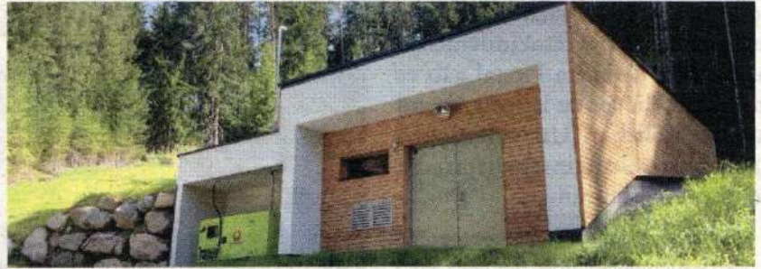
Das neue Trinkwasserkraftwerk in Roppen, das am Freitag, dem 27. September, um 16.30 Uhr besichtigt werden kann.
