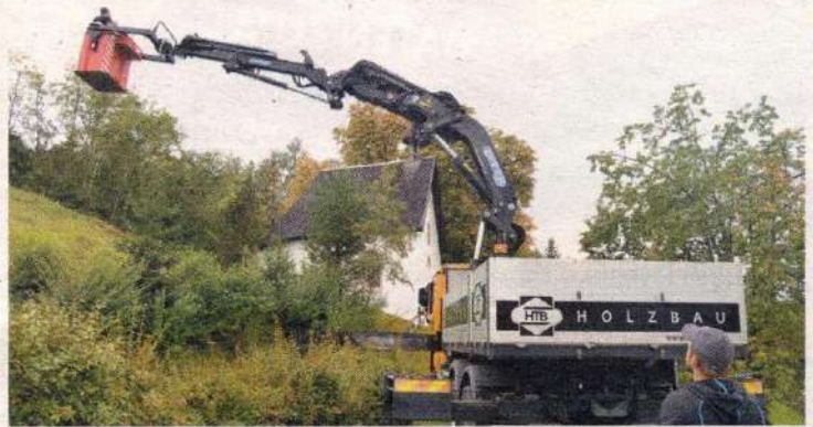
Mit dem „HTB“-Kran ging es auf das Kapellendach.
