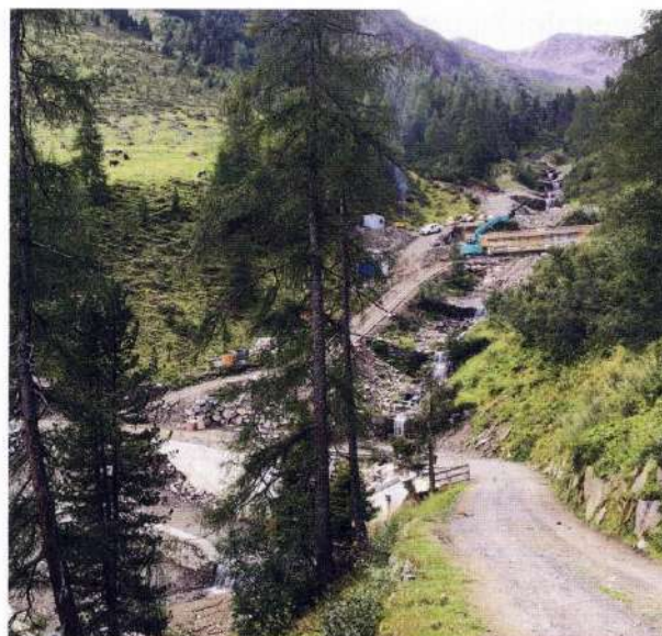
Die Teams der Wildbach- und Lawinenverbauung arbeiten derzeit an der Erneuerung der Geschiebestufen im obersten Bereich.
