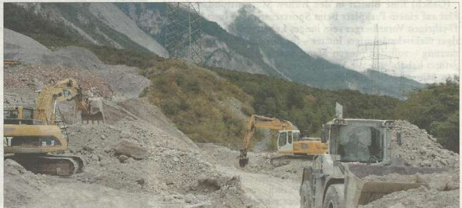
Mit schwerem Gerät wurde im Gewerbegebiet Roppen die Straße wieder befahrbar gemacht.
