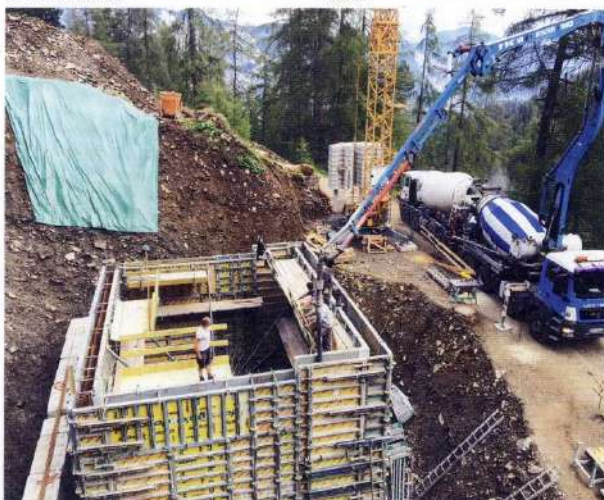
Die neue Quellstube steht kurz vor der Fertigstellung.
