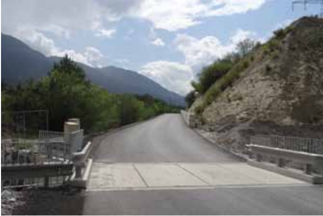
Die neue Brücke an der östlichen Straßeneinbindung Foto: gem
