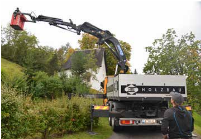
Mit dem „HTB“-Kran ging es auf das Kapellendach.
