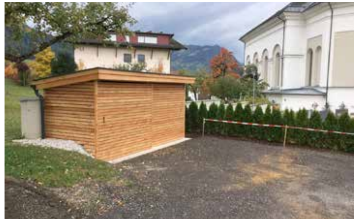
und das neu errichtete Lager für Material.
