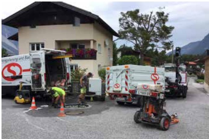
Die Spezialfirma Schafferer bei der Sanierung der beschädigten Kanaldeckel in der Wolfau. Foto: Günter Neururer
