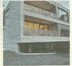
Die Tiefgaragenplätze können bereits von den Eltern der Kindergarten- und Kinderkrippenkinder genutzt werden.
