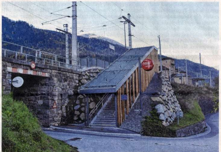
Die Maßnahmen am Bahnhof Roppen haben mehr als drei Millionen Euro gekostet. Dazu zählt der Stiegenaufgang zum Bahnsteig 2 – der barrierefreie Zugang befindet sich an anderer Stelle weiter hinten.
