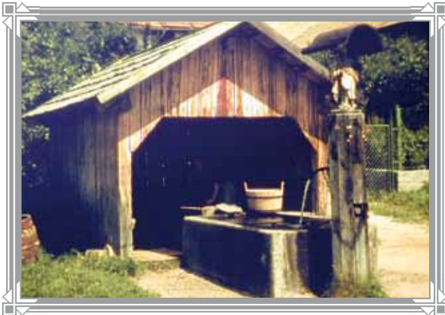
Früher war noch ein „Brunnenhüttl“ angebaut Foto: Chronik
