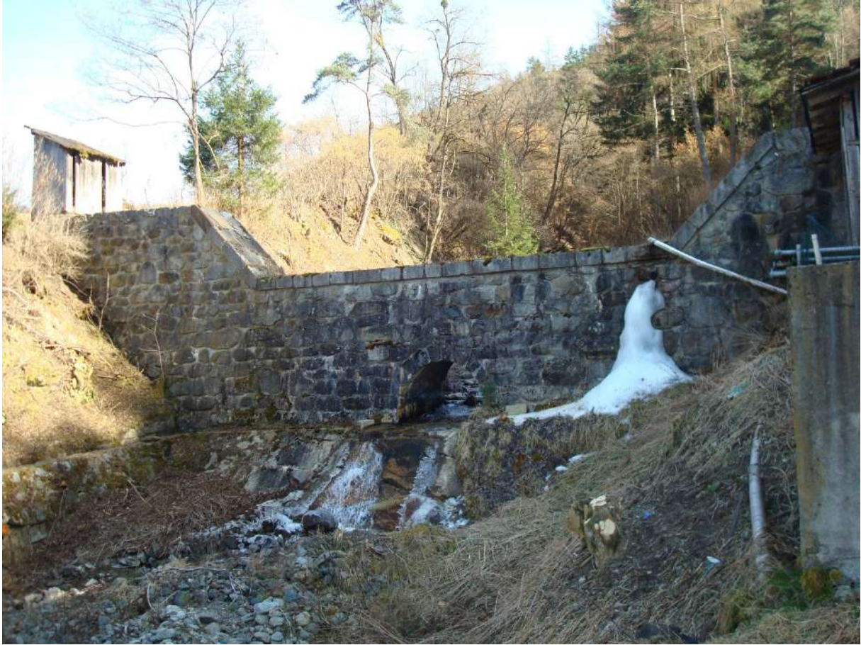
Abbildung 2: Die Geschieberückhaltebecken werden optimiert.
