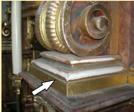
vollständiger Abrieb der Vergoldung an den Kanten; abgeblätterte Fassung am Altaraufbau, fehlendes Schnitzwerk an der Altarmensa
