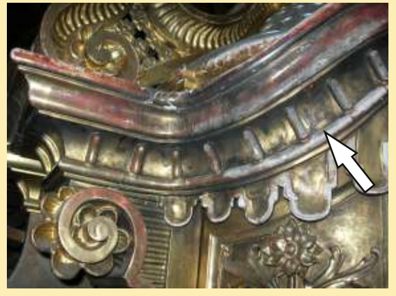
Verschmutzung durch Kerzenruß und Wachsspritzer, abgebrochene Glieder der Figuren, Schäden durch Reißnägeln
