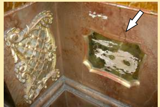
vollständiger Abrieb der Vergoldung an den Kanten; abgeblätterte Fassung am Altaraufbau, fehlendes Schnitzwerk an der Altarmensa
