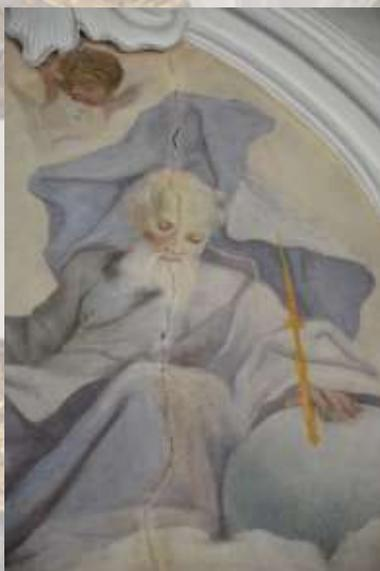
*Links u. rechts: Schäden an Stuck und Risse durch die Fresken im Gewölbe
