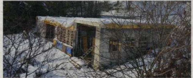
Der ohne entsprechende Genehmigung errichtete Rohbau.
