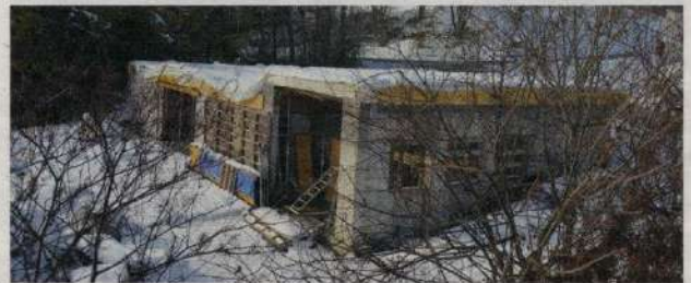
Der ohne entsprechende Genehmigung errichtete Rohbau.
