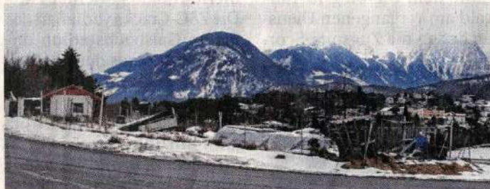
Der Bereich neben der prominent gelegenen Auffahrt zum Roppener Gewerbegebiet soll „aufgeräumt“ werden.
