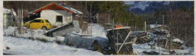
Das Bienenhaus an der Bundesstraße muss abgerissen werden. Derzeit läuft an der BH Imst das Vollstreckungsverfahren. RS-Fotos: Schnöll
