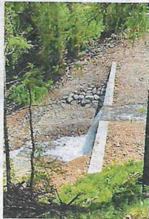
Neu errichtete Verbauung oberhalb der Maisalm.
