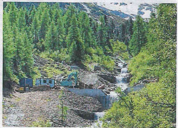
Archivbilder aus dem Jahr 2019, die Verbauung im oberen Bereiches des Leonhardsbach war noch im Gange.
