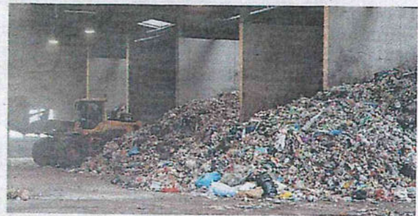
In dieser Halle wird der Restmüll gelagert bevor er in die Verbrennungsanlage nach Wels gebracht wird. Fotos: Siegele
