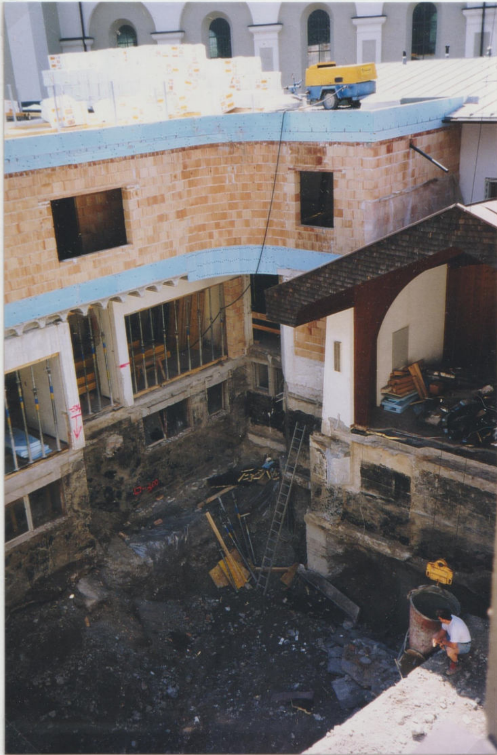
Baugrube für das Probe- lokal der Musikkapelle im Kulturzentrum, Sommer 1999
