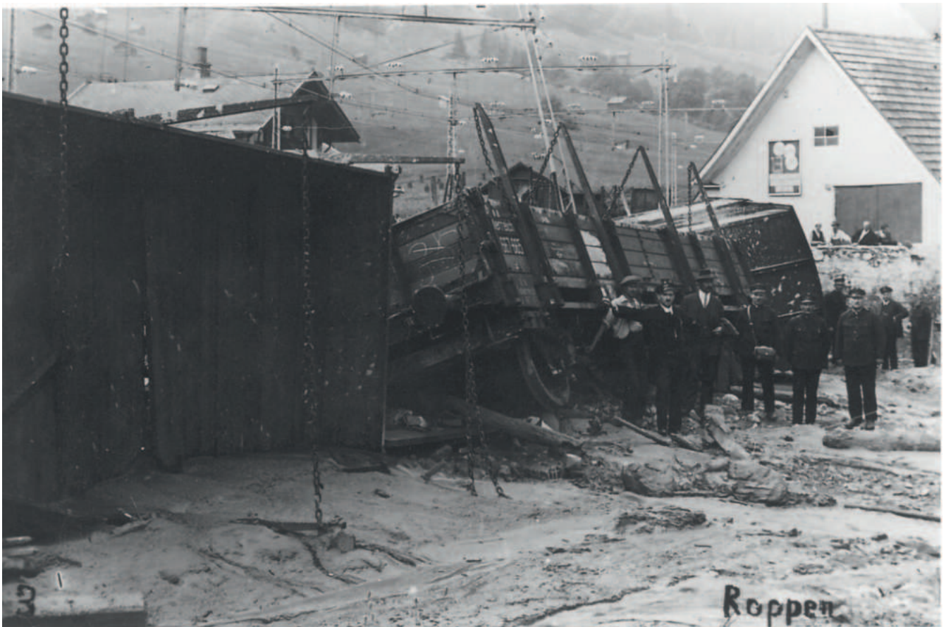
Durch eine Mure verschütteter Bahnhof Roppen 1928
