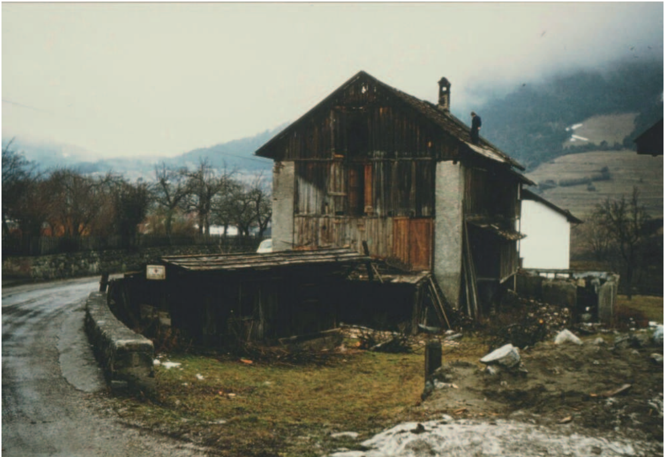
Abbruch Bäckerei des "Kässe" Franz Köll - ehemalgig Rudigier 1977
