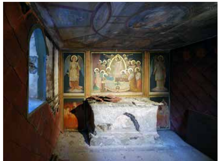
Die „untere Kapelle“ vor der Restaurierung.
