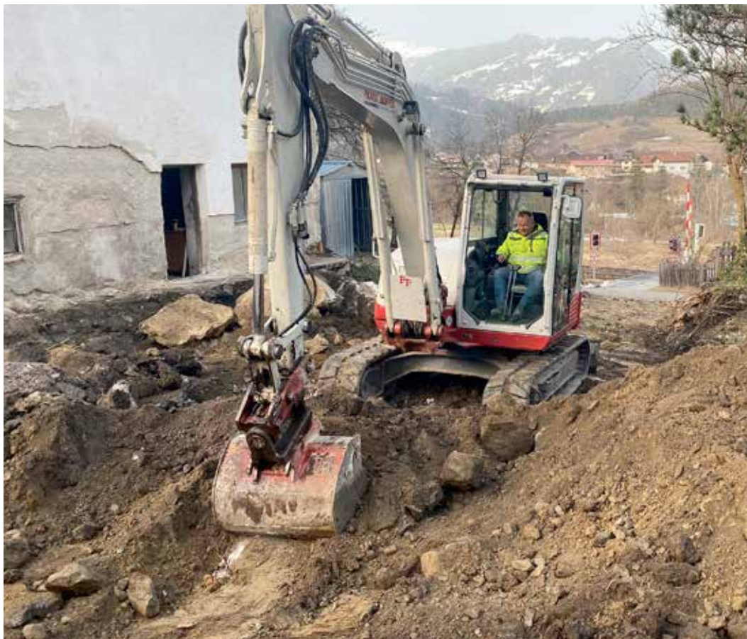
Baggerfahrer Toni Huber sorgte für einen ordentlichen Spatenstich bei der neuen Zufahrt zum Bahnschranken. Foto: Mayr
