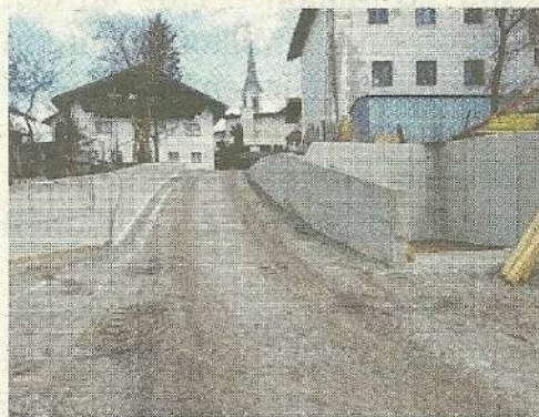
Einige Betonarbeiten wurden schon abgeschlossen.
