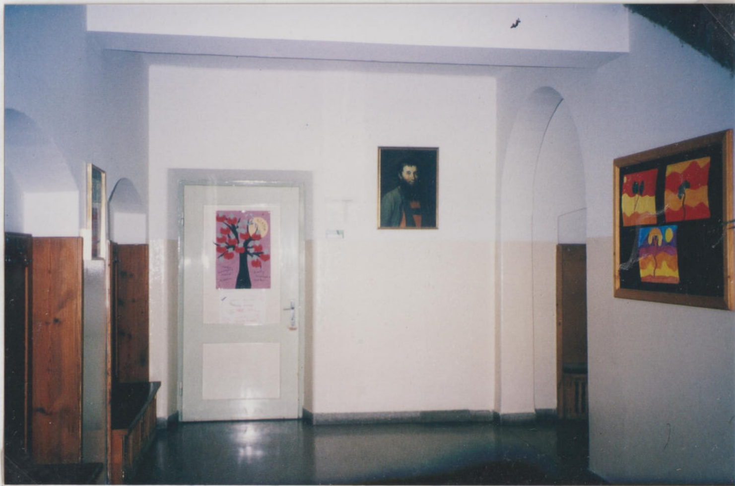
Hausgangbereich im Parterre vor dem Umbau/1994
