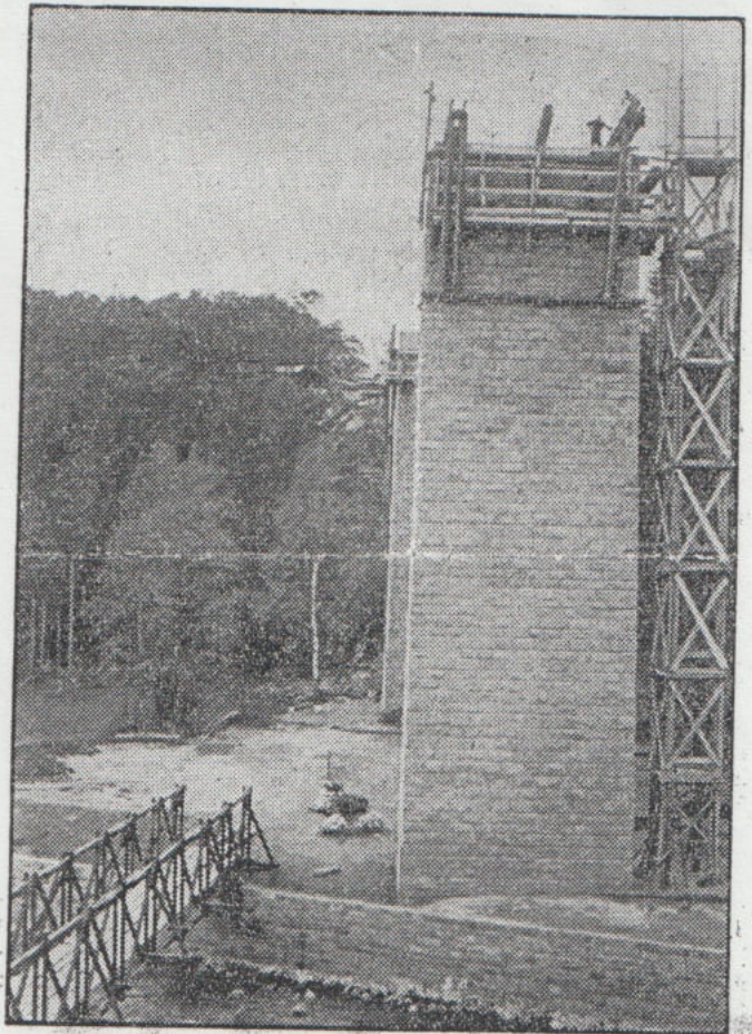
Die 35-Meter hohen Pfeilerfürme der werdenden Brücke über die Deztaler Ache
