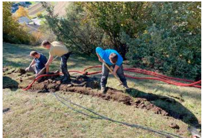
Die fleißigen Helfer bei den Instandhaltungsarbeiten am Burschl.
