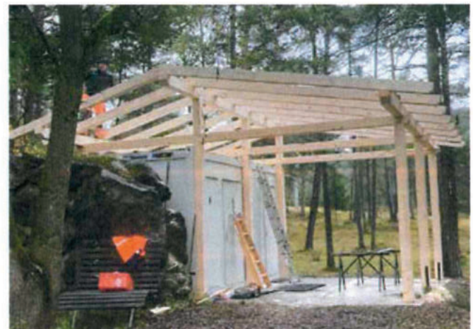
Die WC-Anlage wurde großzügig umgebaut.
