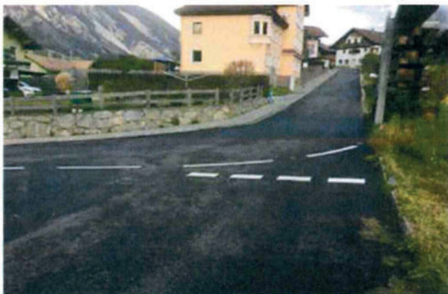
Sanierte Straße von der Kreuzung Bahnhof bis zur Brücke.
