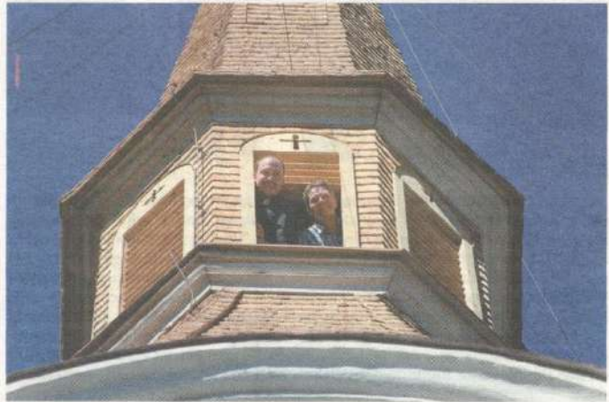
Kurz bevor die Dachdecker ihre Seile und Aufzüge abbauten, bestiegen der Roppener Vizebürgermeister Günter Neururer und Pfarrer Johannes Laichner (l.) zur Abnahme der Arbeiten den Kirchturm.
