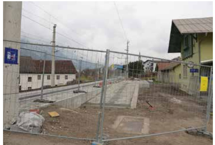
Noch ist der barrierefreie Bahnsteig 1 in Arbeit.
