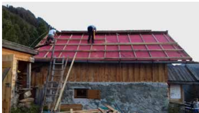
Aufwendige Renovierung des Daches.
