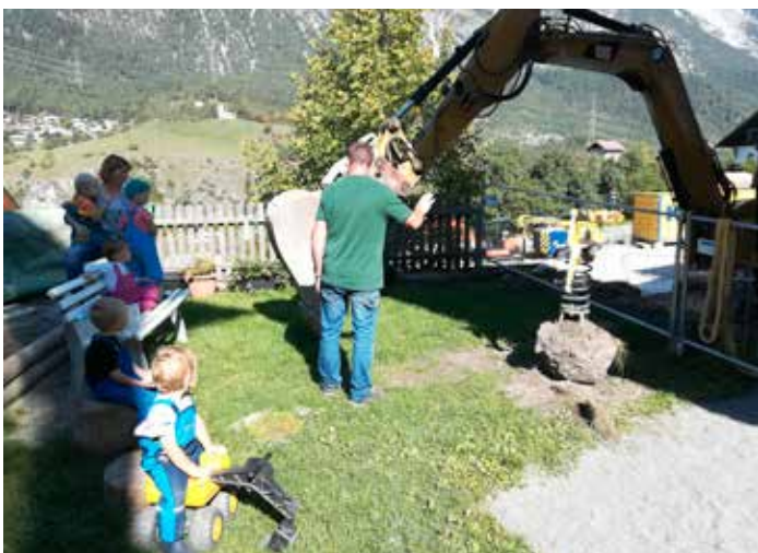
Die Kinder hatten viel Spaß bei der Baustellenbeobachtung.
