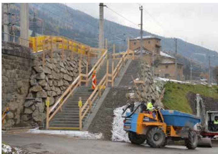
Die neue Treppe, über welche die Bahnkunden zu den beim Bahnsteig 2 ein-fahrenden Zügen gelangen werden.
