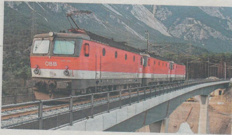
Mit 260 Tonnen wurden die Schwingungen der Brücke genauestens gemessen.
