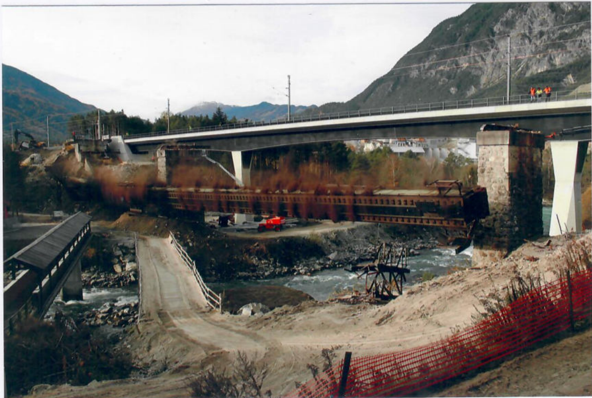
8. November 2011: Die alte Brücke donnert in die Tiefe. Erbaut nach dem Plan von Josef Liebhart 1883 hat sie nach fast 130 Jahren ausgedient.
