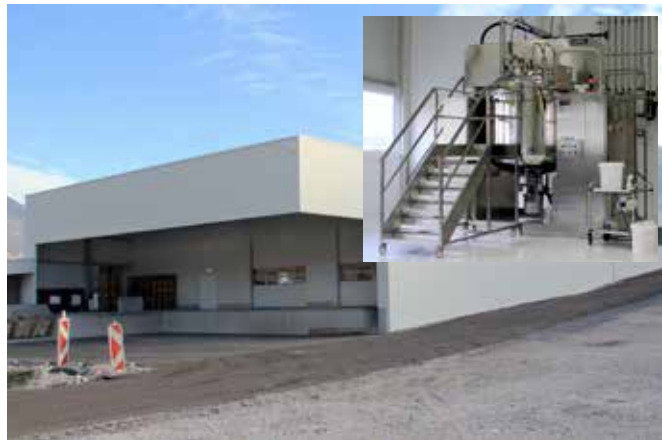
Das Betriebsgebäude von „A pure green source“
