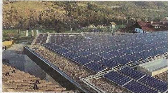
Am Dach des Turnsaals wurde eine PV-Anlage errichtet.
