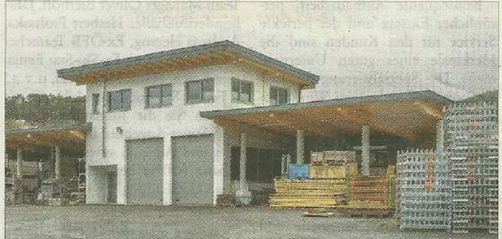
Das neu errichtete Betriebsgebäude auf dem in Roppen gelegenen Betriebsareal von „Gerüstbau Seifert“ mit Firmensitz in Tarrenz.
