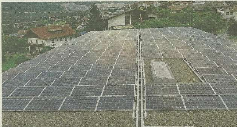
Insgesamt 82 Photovoltaikmodule befinden sich jetzt am Dach des Roppener Turnsaals.
