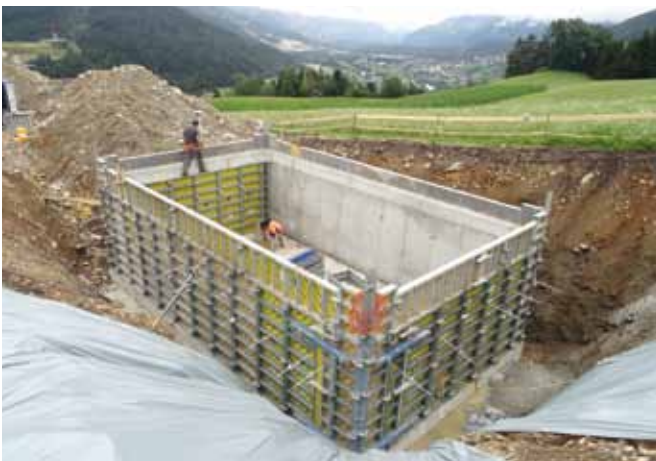
Das neue Löschwasserbecken in Hohenegg wurde bereits fertig betoniert.
