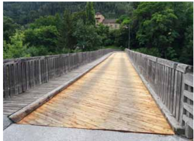
Der Holzbelag der Innbrücke wurde von den Gemeindearbeitern fachgerecht erneuert.
