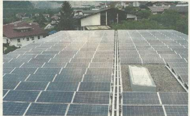
Die rund 470 Quadratmeter der Dachfläche wurden fast zur Gänze benötigt, um die 82 Module mit je 65 W montieren zu können.
