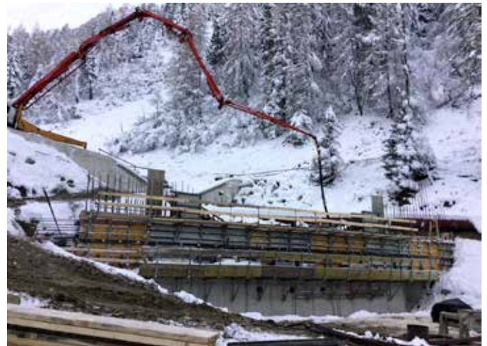
Betonieren bei winterlichen Bedingungen.
