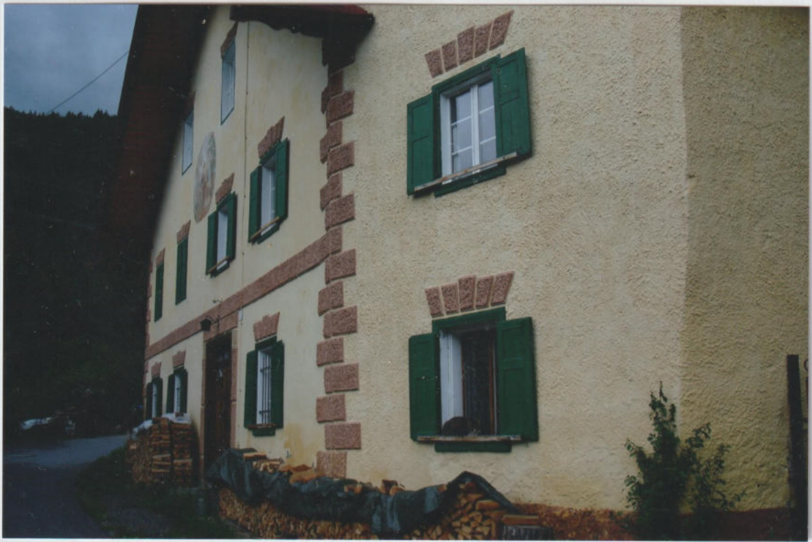
Das ehemalige Gasthaus „Trankhütte“, Hausnummer. 1 wurde von der Familie Sporer aus Innsbruck renoviert und dient als Zweitwohnsitz
