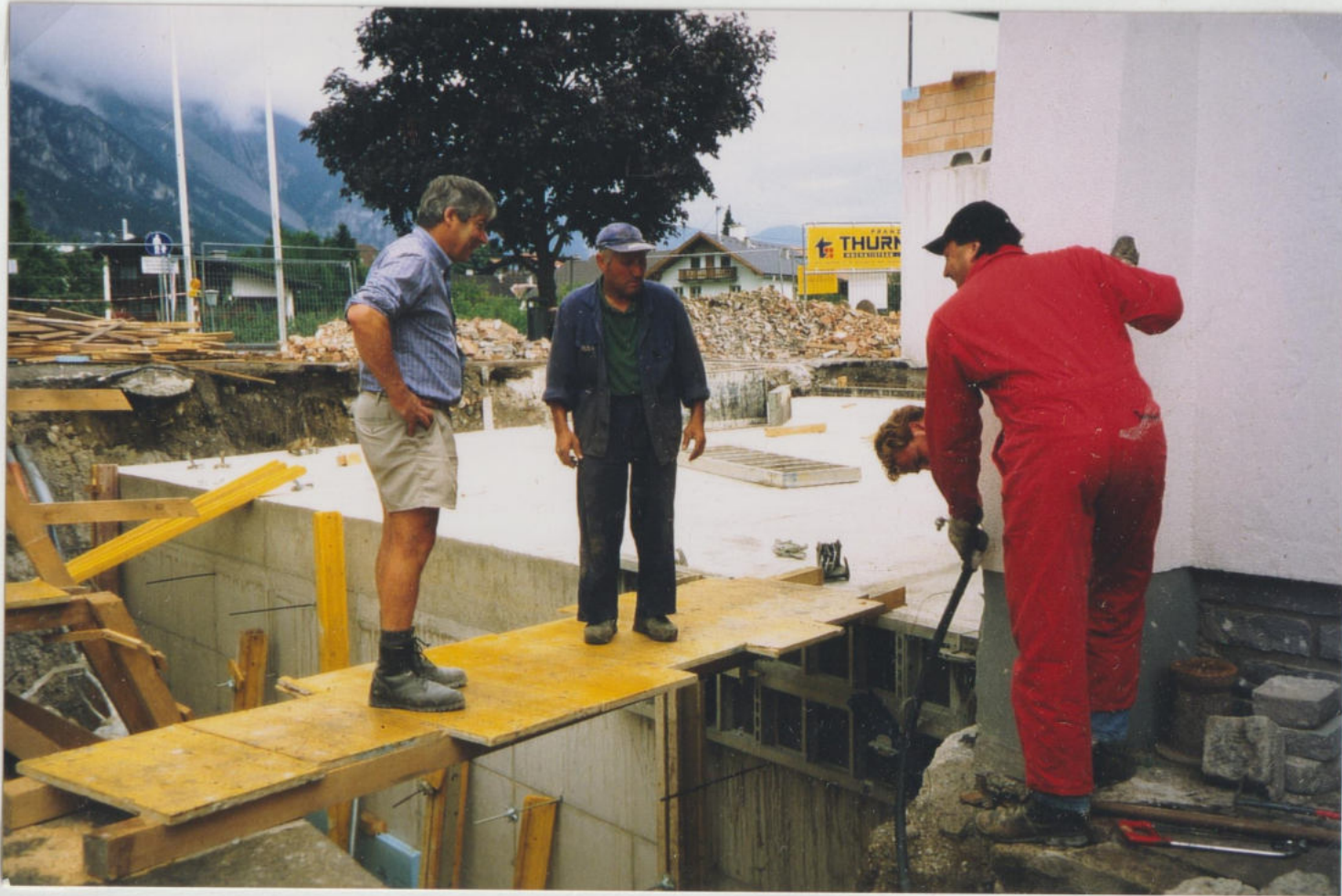
Das „unterirdische“ Probelokal der MK im Rohbau (R.Natter, J.Klocker u. Installateure) Sommer 99
