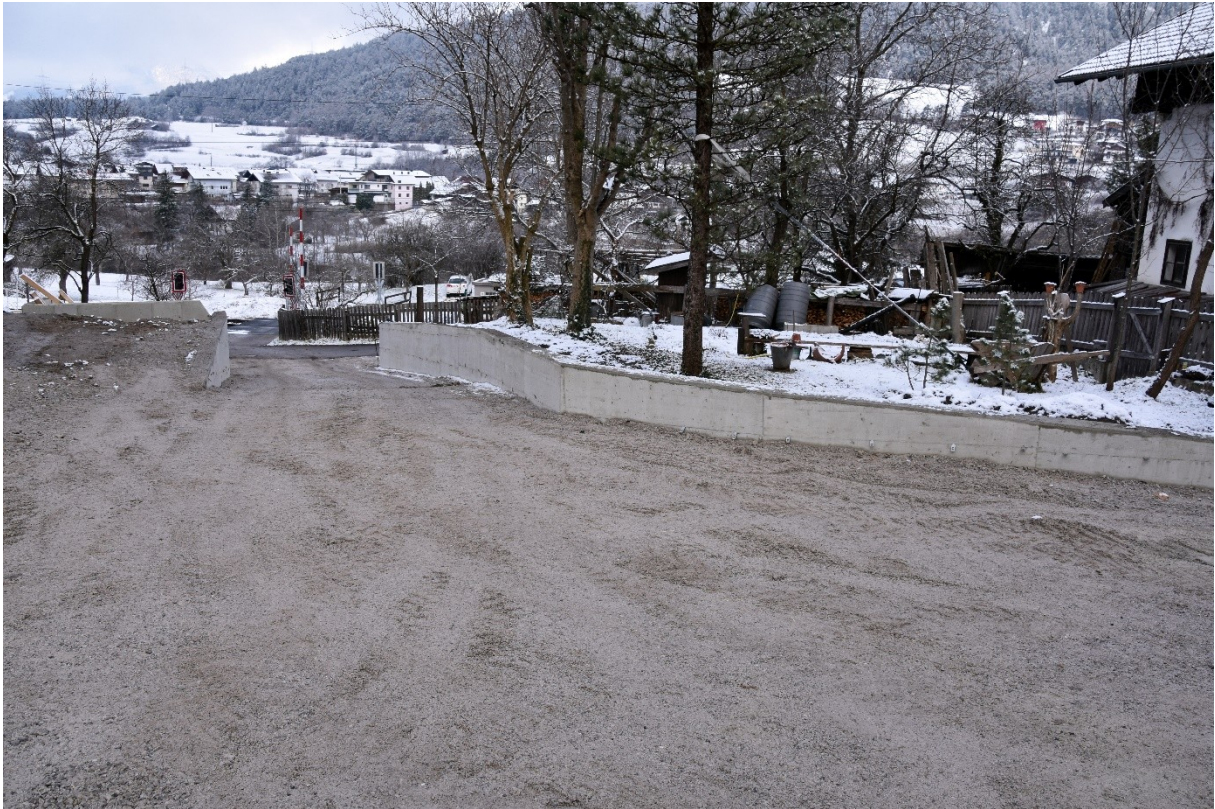
März 2021 – Bau der neuen Straße zur Innkniesiedlung – Riedegg.
