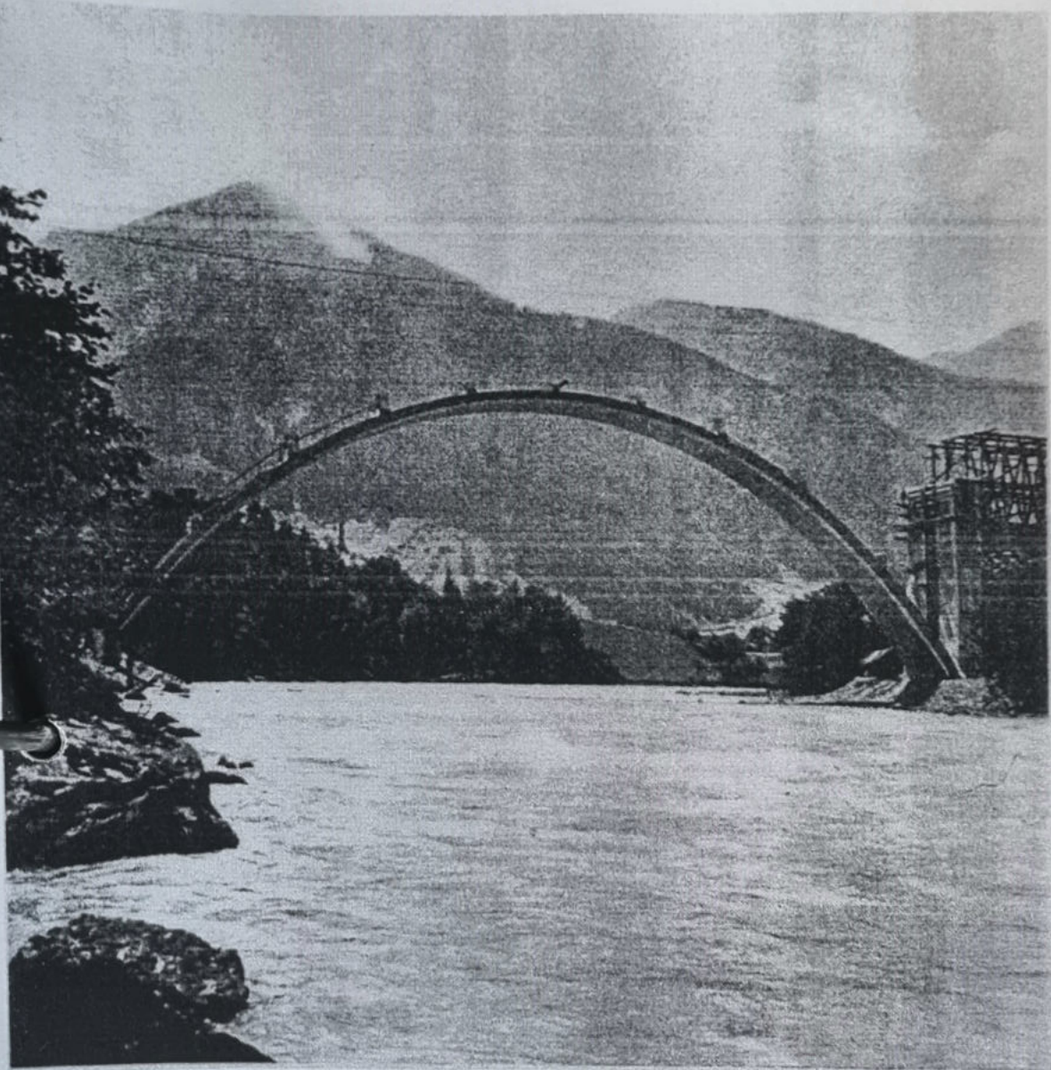
Juni 1938. Der freistehende Brückenbogen von 68 m Länge und 26 m Höhe über dem bereits mit Gletscherwasser gefüllten Innfluß.
