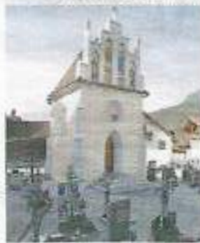
Die gesamte Lourdeskapelle erstrahlt innen wie außen in neuem Glanz.
