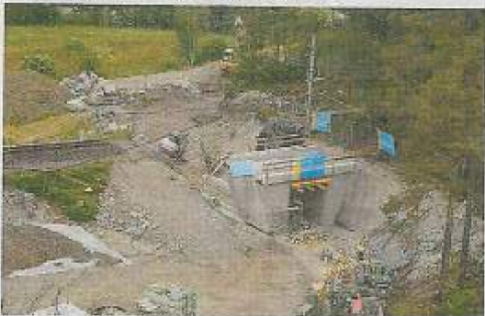
Die Unterführung beim Weiler Ötzbruck, die ebenfalls am vergangenen Mittwoch in Position gebracht wurde.
