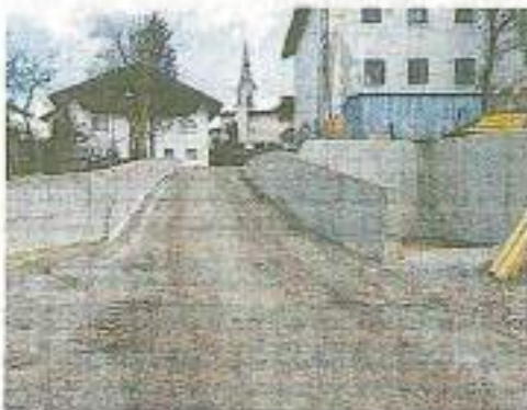
Einige Betonarbeiten wurden schon abgeschlossen.
