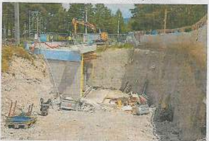
Nach Fertigstellung der Unterführung können auch Feuerwehr-Tankwagen und größere Rettungsautos die Riedegg-Siedlung anfahren.
