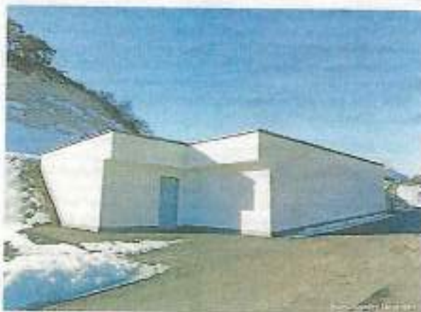
Das Löschwasserbecken für den Roppener Gewerbepark ist bereits fertiggestellt.
