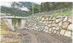
Die Unterführung nach Ötzbruck nach in der Bauphase.
