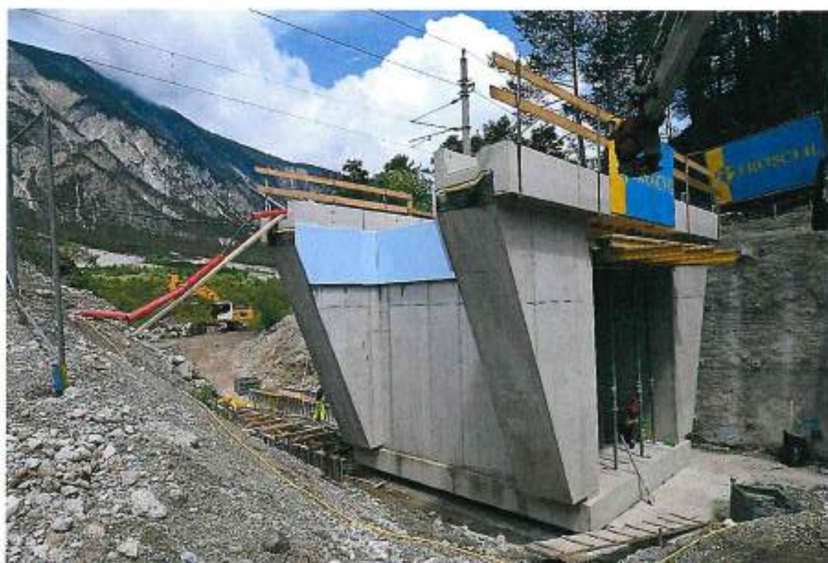
Baustelle Zufahrt Ötzbrugg
