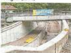
Die Bauarbeiten gestalteten sich sehr umfangreich.
