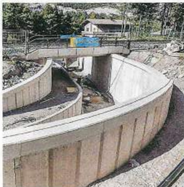
Am 24. September soll die neue Unterführung nach Riedegg offiziell ihrer Bestimmung und somit für den Verkehr freigegeben werden. Foto: BWS
