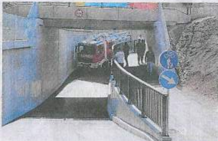
Ein historisches Bild: Erstmals, nach 30-jähriger Vorlaufzeit, kann ein Feuerwehrauto unter der Bahn zum Roppener Ortsteil Riedegg fahren. Foto: Parth
