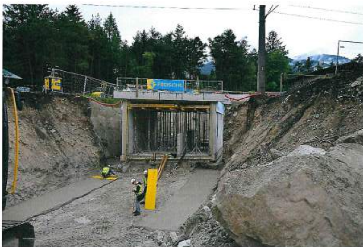
ÖBB Baufortschritt beider Unterführungen am 8. Juni 2021 Baustelle Zufahrt Riedegg
