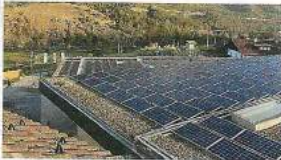
Am Dach des Turnsaals wurde eine PV-Anlage errichtet.
