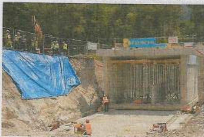
Millimeter für Millimeter wurde die tonnenschwere Unterführung in Richtung Bahntrasse geschoben.
