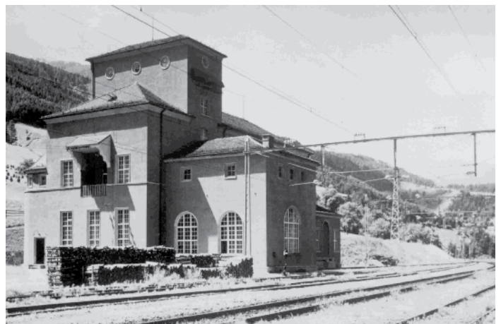
Das von Clemens Holzmeister geplante und 1922 bis 1924 gebaute Umspannwerk - das ehemalige Kraftwerk der Arlbergbahn.
