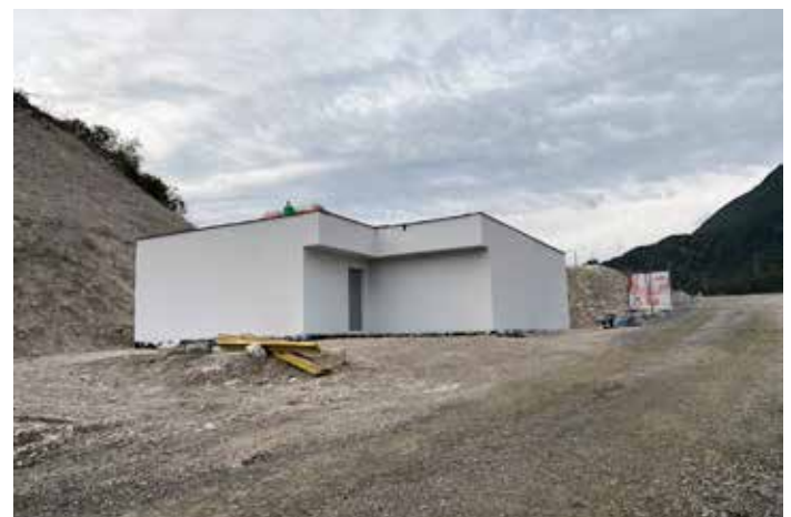
Der neue Löschwasserbehälter im Gewerbepark Roppen
