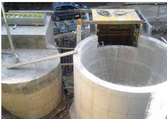
Gute Baufortschritte bei der WVA Hohenegg Foto: G. Neururer
