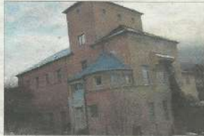
Das Unterwerk, leerstehender Holzmeisterbau, 1922 als Umspannwerk der Bahn errichtet, beflügelt die Phantasie der RoppnerInnen.
