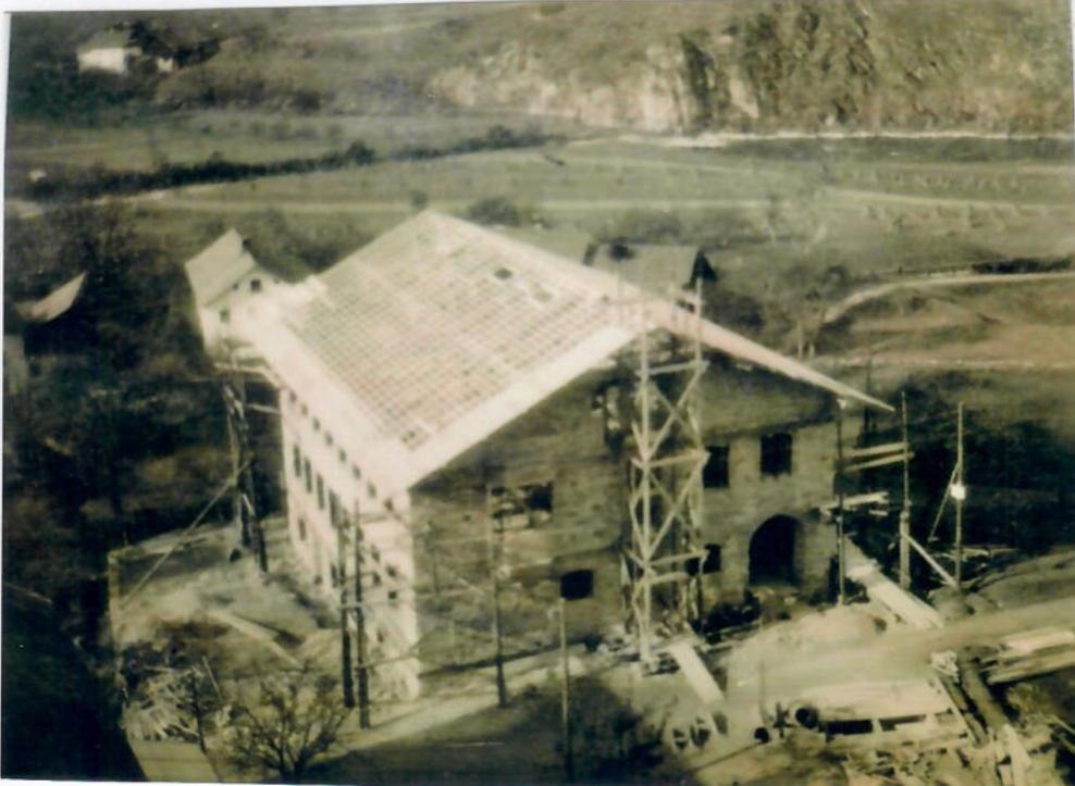
Baustufe im Herbst 1950, Beginn der Bauarbeiten im Frühjahr; der Aushub erfolgte händisch; die Bevölkerung leistete entweder Frondienste oder einen finanziellen Beitrag
