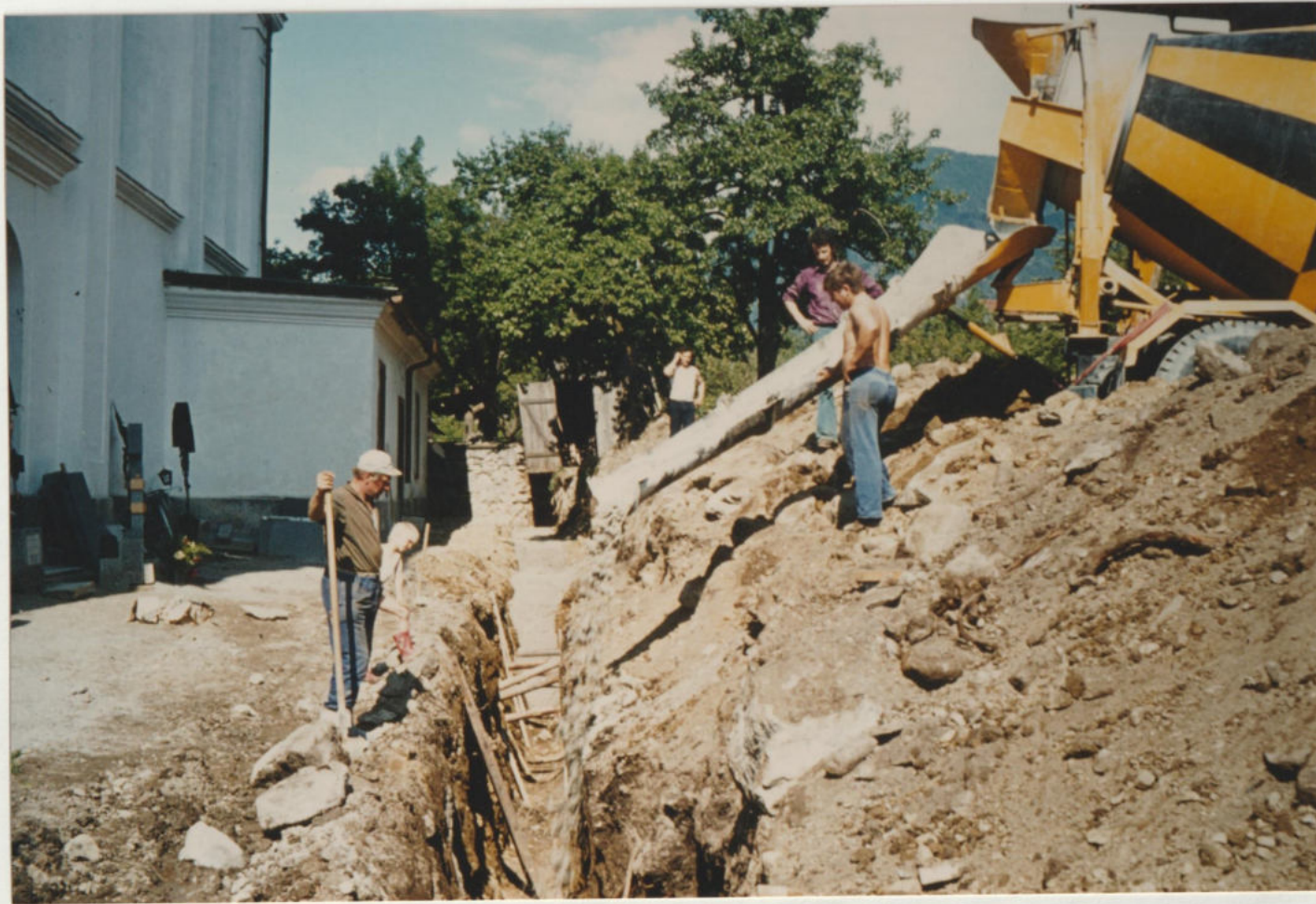
Bau der neuen Friedhofmauer 1980
