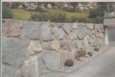
Hangsicherung durch das Errichten von Natursteinmauern ... Fotos: Erdbau Prantl
