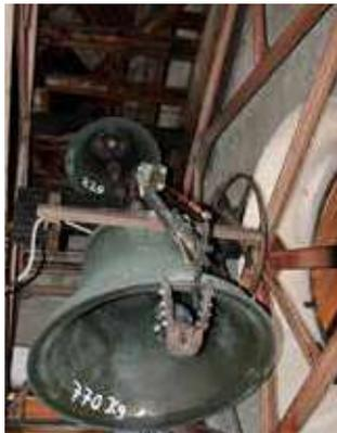
Die elektronische Steuerung und die Hauptuhr werden komplett erneuert. Die Motoren werden überprüft; einer muss erneuert werden. Die Klöppel werden auf Risse überprüft, neu ausgeglüht und die Aufhängevorrichtungen erneuert. Das Antriebssystem wird von derzeit Ketten auf Keilriemen umgestellt. Der Glockenstuhl, der jetzt aus Eisenträgern besteht, wird in Holz errichtet, was aus Sicherheitsgründen notwendig ist und auch für einen harmonischeren Glockenklang sorgen sollte.
