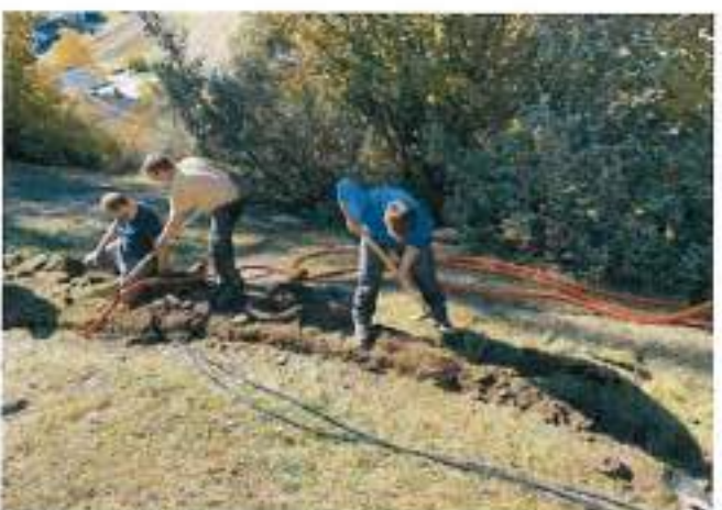
Die fleißigen Helfer bei den Instandhaltungsarbeiten am Burschl.
