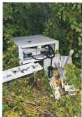
Der völlig demolierte LWL-Verteilerkasten. Foto: Ebi Schell
