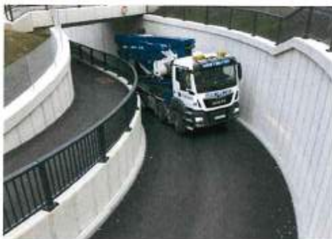
Endlich kann ein Beton-Pumpfahrzeug nach Riedegg fahren.
