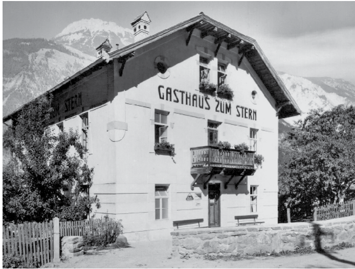
Das Gasthaus Stern wurde um 1900 erbaut.
