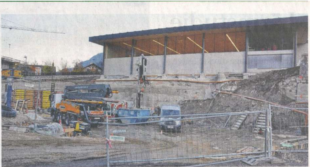
Die Arbeiten für das neue Kinderbetreuungszentrum schreiten stetig voran. Noch heuer soll die Tiefgarage des Kindergartens betoniert werden. Foto: Dorn
