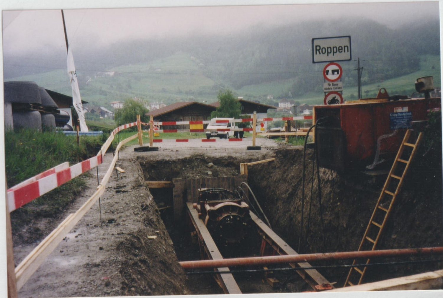
Kanalisation oberhalb des Burschlhofes Frühjahr 1997
