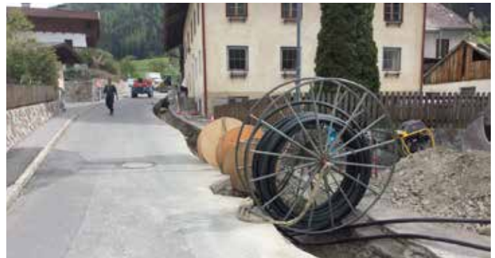
Grabungsarbeiten Richtung Oberängern.
