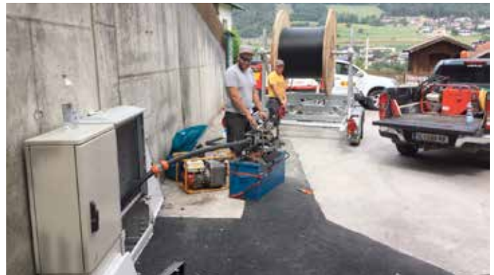
Kabel einziehen.
