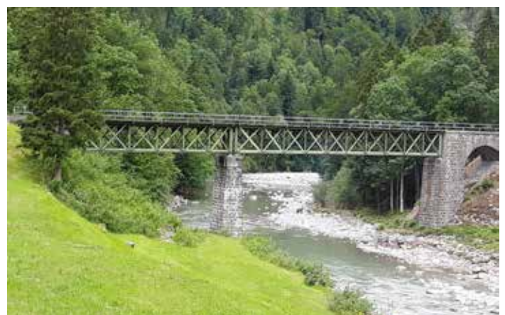
Brücke der ehemaligen Bregenzerwaldbahn.
