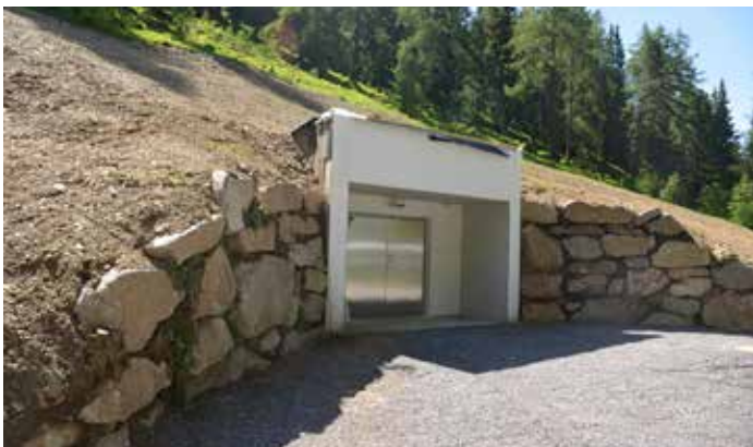
Die neue Quellwasserstube neben dem Weg zur Reichenbachalm.
