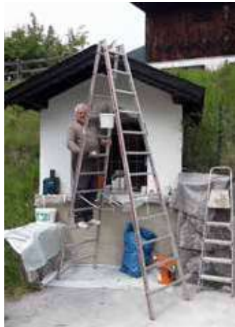
Nach den Bauarbeiten wurde die Kapellen bei der Holzbrücke neu bemalt.
