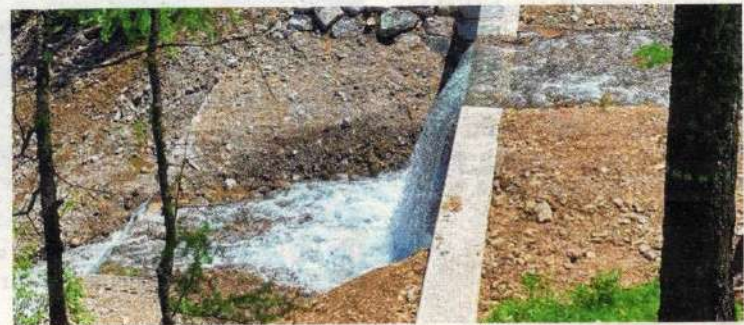
Die neu errichtete Verbauung im oberen Bereich des Leonhardsbachs oberhalb der Maisalm wurde erst unlängst fertiggestellt.
