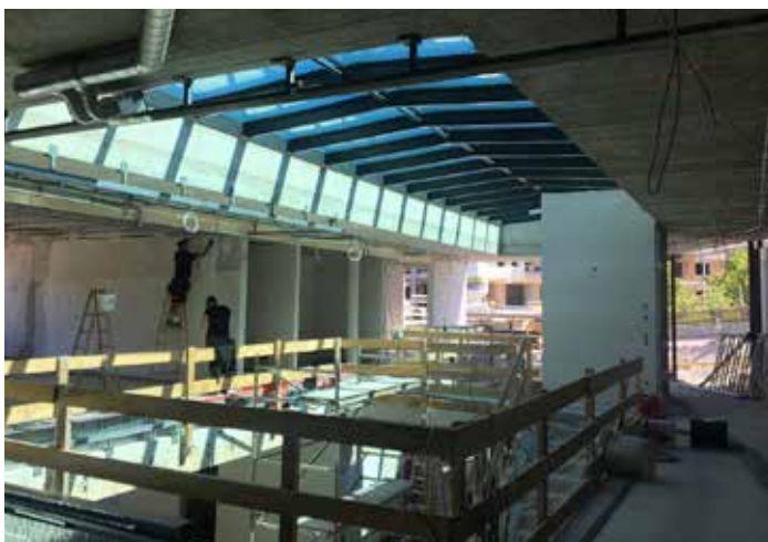
Künftiger Eingangsbereich des Kinderbetreuungszentrums mit Treppenaufgang.
