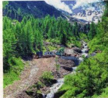
Trotz Verbauungen kommen immer wieder Muren vor.
