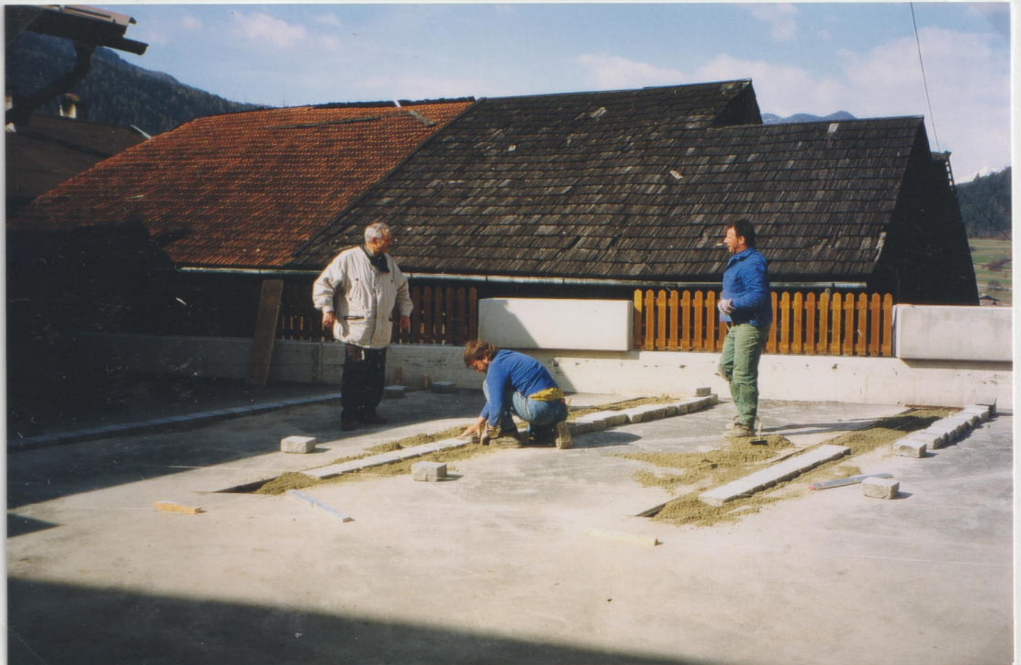
noch sieht man den alten Stadel / Abriss Früh.2000
