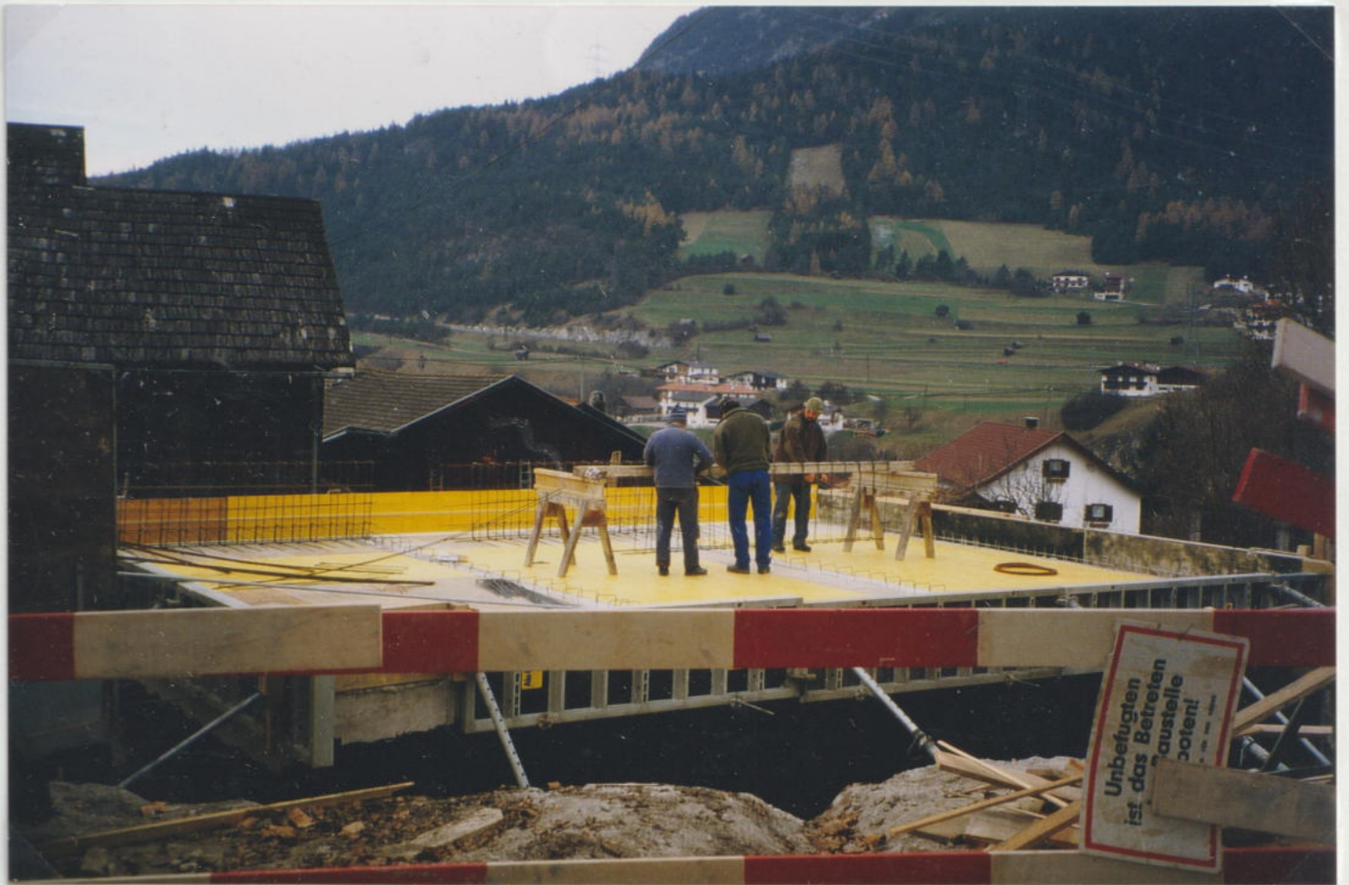
Anlegen des Parkplatzes zwischen Schulhaus und Geschäft / darunter Garage „Klöse Pepi“, 1993
