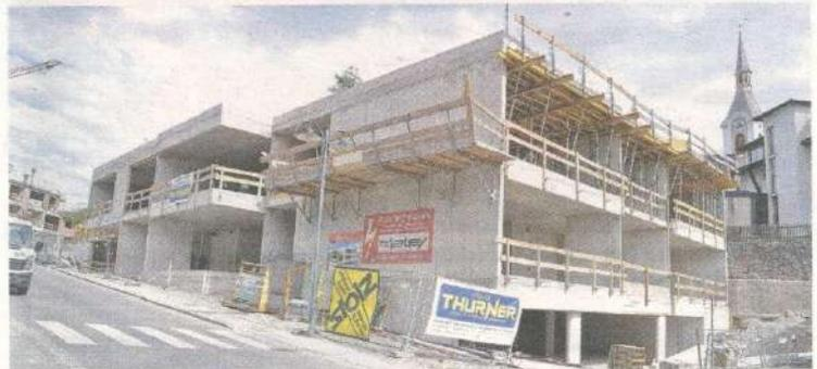
Das Dach (bis auf die Verglasung) ist oben, nun können die restlichen Schalungen entfernt werden.
