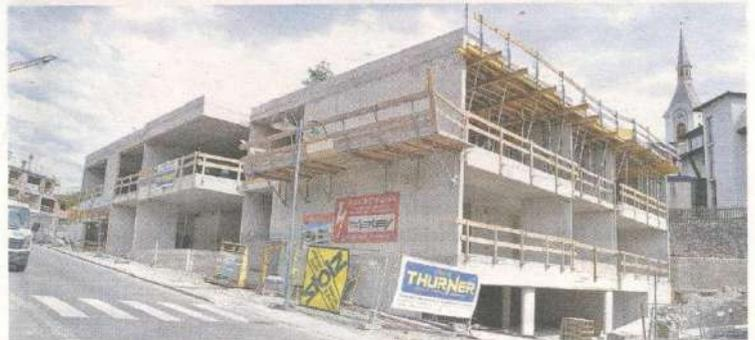
Das Dach (bis auf die Verglasung) ist oben, nun können die restlichen Schalungen entfernt werden. RS-Fotos: Dorn
