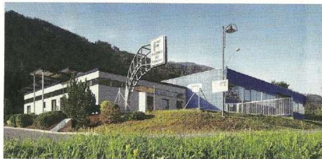
2004 übersiedelte die Firma Falkner Maschinenbau in das neue Betriebsgebäude in Roppen, Lehne 64. Foto: B. Köll
