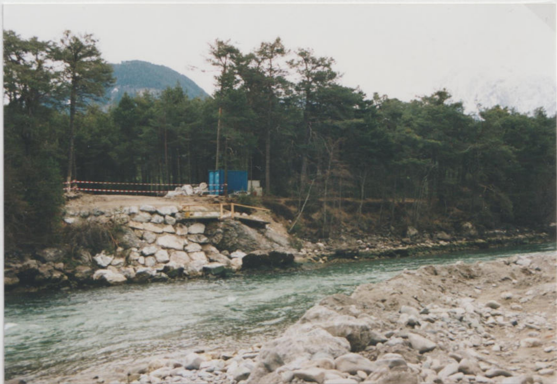
Schrägseilbrücke - Frühjahr / Sommer 2001
